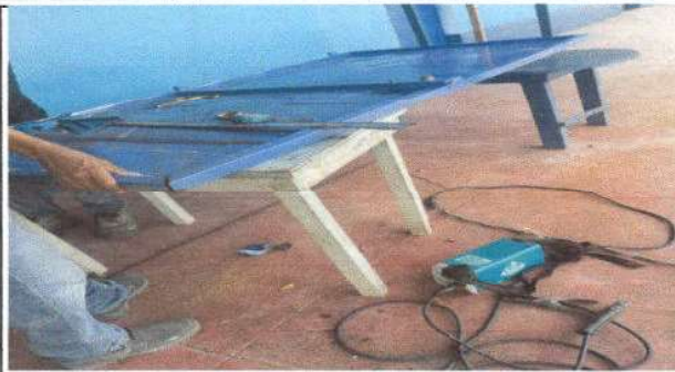
Foto 1 : Mantenimiento de puertas
