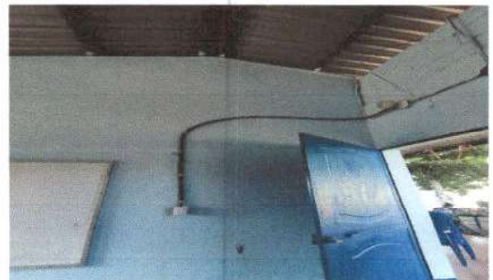
Foto 4: Sustitución de tendido eléctrico
