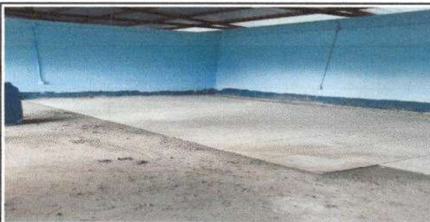
Foto 5 : Sustitución de piso de concreto por piso cerámico
