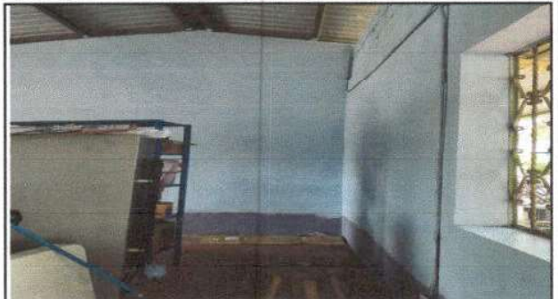
Foto 2 : Pintura de aulas
