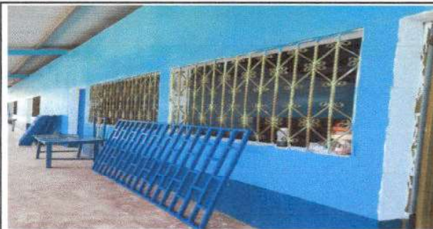
Foto 3: Sustitución de Balcones de aulas
